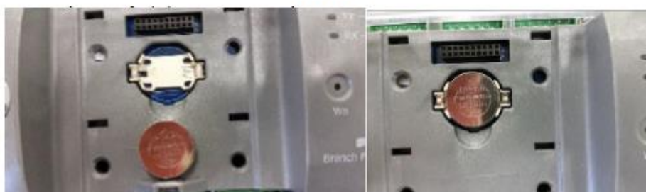
Рисунок 35 – Установка (замена) батареи
